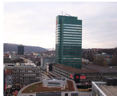
Sparkassenhochhaus, erbaut 1975, Archiv Jürgen Elberding
