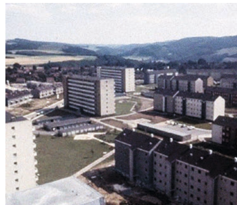
Blick vom Hochhaus auf neue Siedlung nach 1960, Archiv Arbeitskreis „Emst einst und jetzt“
