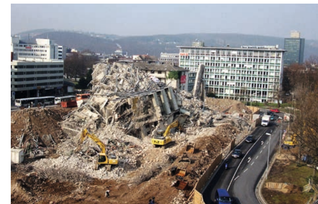
Sparkassenhochhaus, Abriss 2001, nach 26 Jahren, Archiv Jürgen Elberding
