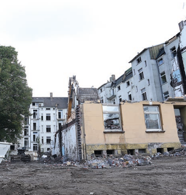
Abbruch Wehringhausen – Block 1, Archiv Kleinrensing
