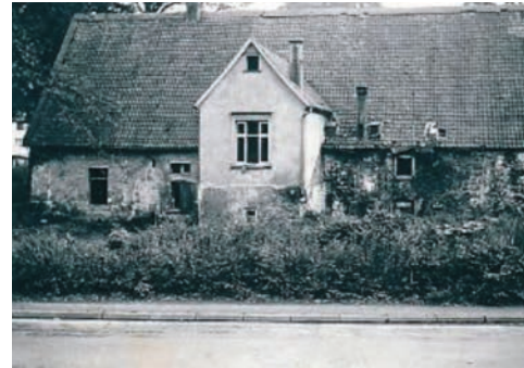
Förster- und Gesindehaus mit Pferdeställen von Haus Dahl.
