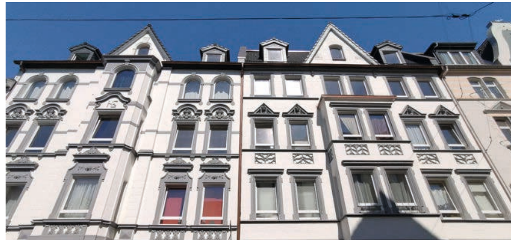
Historische Häuserfassade vor dem Abriss, Foto Johann Dieckmann
