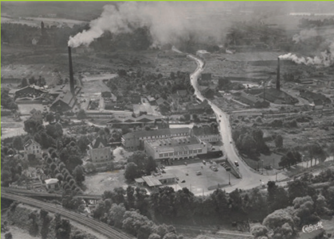
Ziegeleien in Vorhalle, dazwischen die Weststraße
