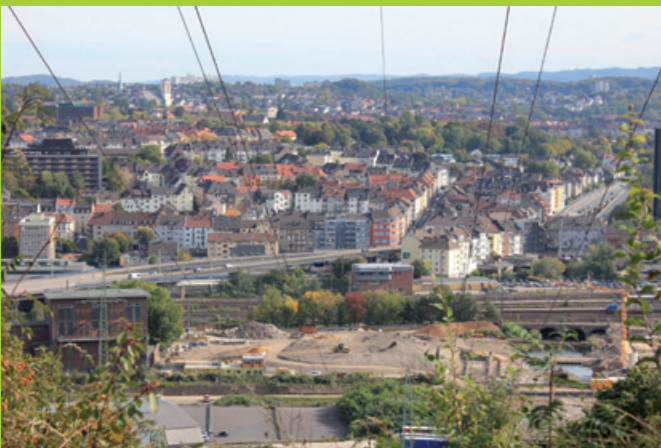
Altenhg. Brücke u. Bahnhofshinterfahung, 2015
