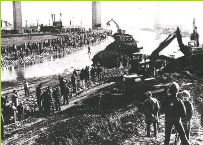
Lennetal, Durchstich am 02.11.78
